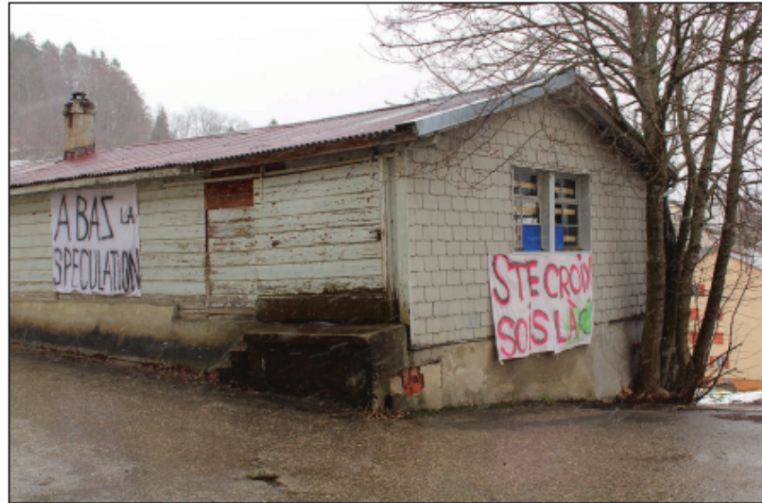
L'utilisation de l'annexe de l'ex-bâtiment Reuge fait toujours débat.
